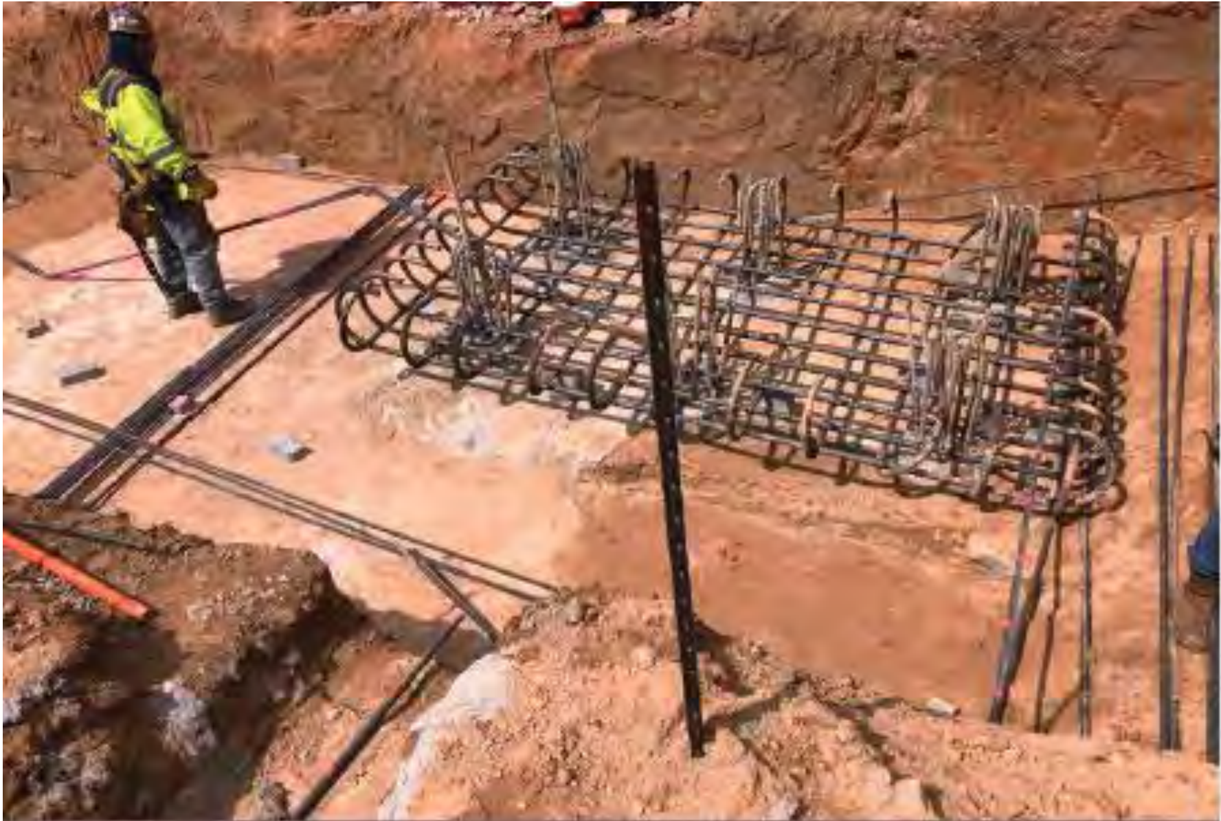
Pile Cap Rebar
