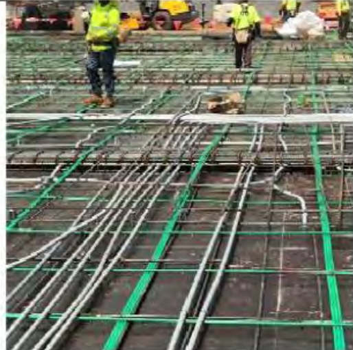
Photo 12 Conduit placement in slab
