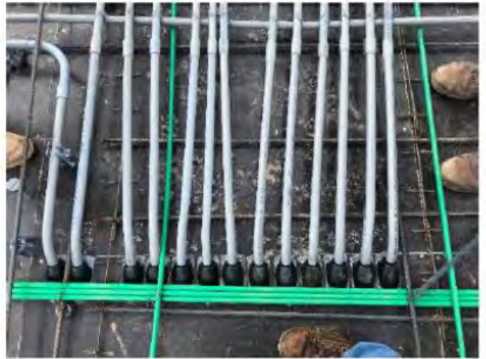
Photo 10 Conduit placement in slab
